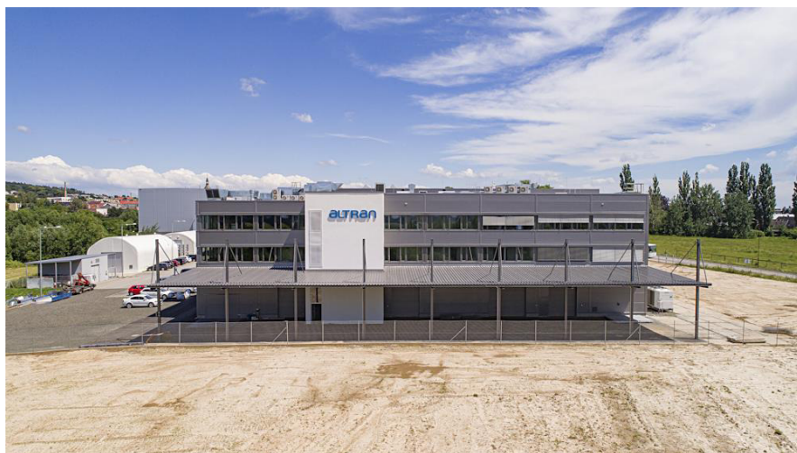
Centrum vývojových služeb, objekt zkušebny Libonice, město Hořice
