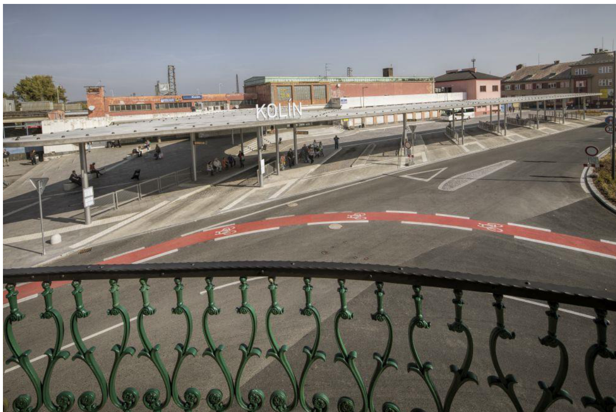
Výstavba dopravního terminálu Kolín
